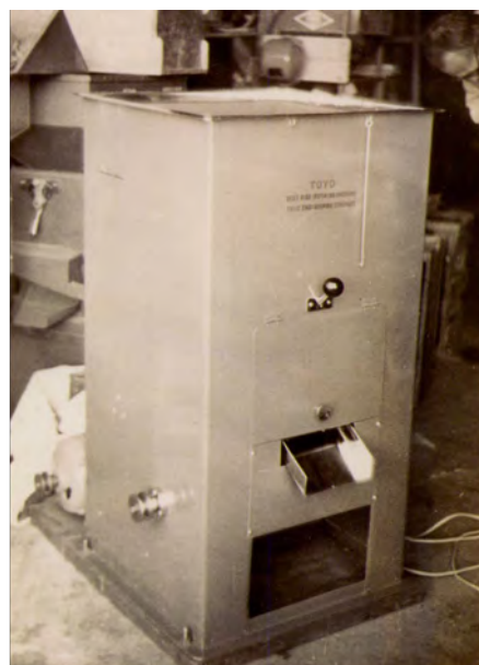
1961年に和歌山で発明された、コメから石粒を取り除く「石抜き機」
